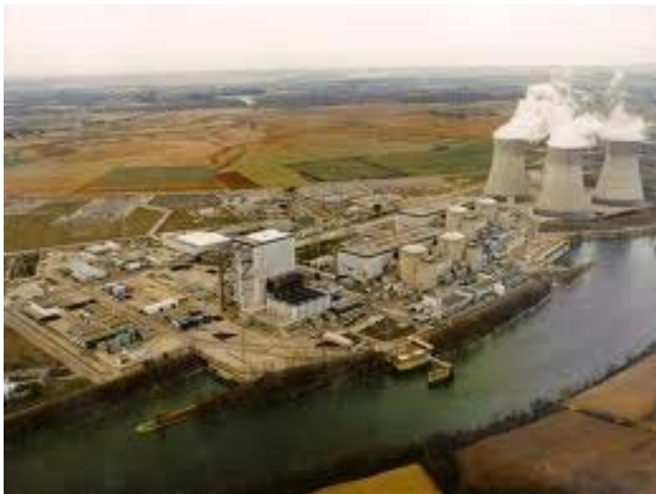
La centrale du Bugey
